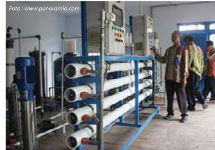
PDAM Kota Banjarmasin mengembangkan instalasi air yang mampu mengolah air laut menjadi air bersih dengan menggunakan teknologi membran. Instalasi ini disediakan untuk melayani penduduk yang tinggal di daerah agak terisolasi, yaitu Pulau Bromo (Kecamatan Banjarmasin Selatan, Kota Banjarmasin). Instalasi dibangun dengan menggunakan bantuan PERPAMSI sebagai penghargaan bagi PDAM Kota Banjarmasin yang terpilih menjadi PDAM terbaik dengan 140 ribu lebih pelanggannya.
